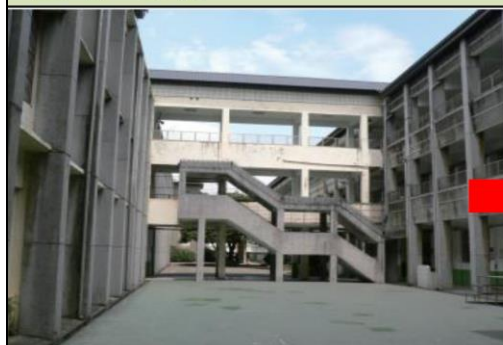
原為老舊樓梯
