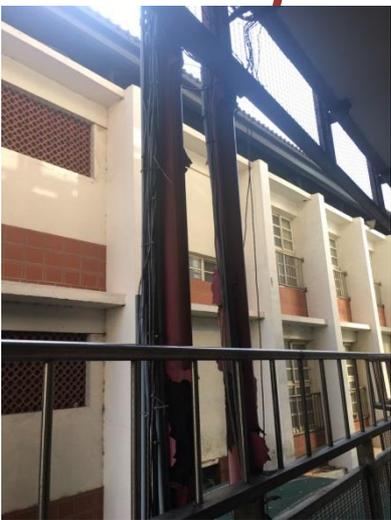
原有水管已老舊鏽蝕
