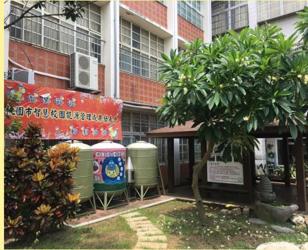
將既有的雨水回收水塔，將「入水」、「出水」、「溢水」管線重新整理回收雨水作為布馬農場灌溉、校園花木澆灌、生態池水源補充。師生合作彩繪，設置「水資源教育」與「智慧節水雨撲滿」解說教學教材，延伸師生學習的範圍，落實「生活節水，節能減碳」的理念！
